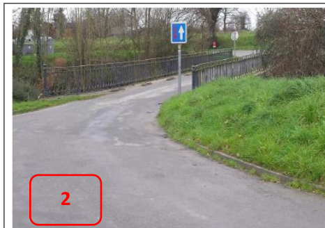
Pont de chemin fer Plancoët KM 26
