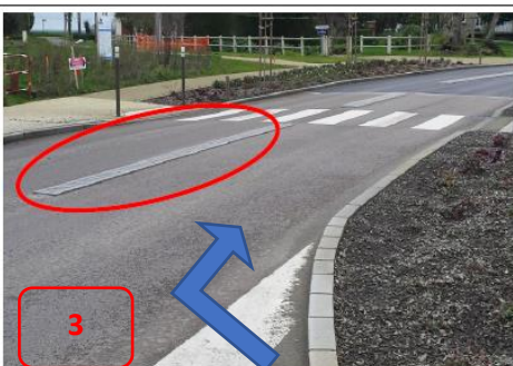
Sortie Corseul pavés centraux KM 39
