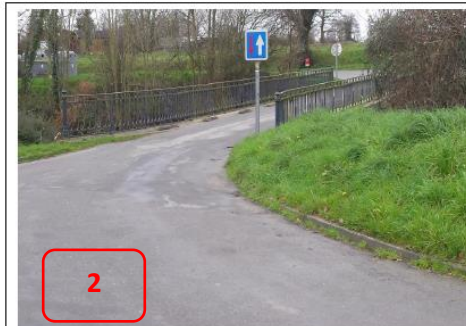
Pont de chemin fer Plancoët KM 26
