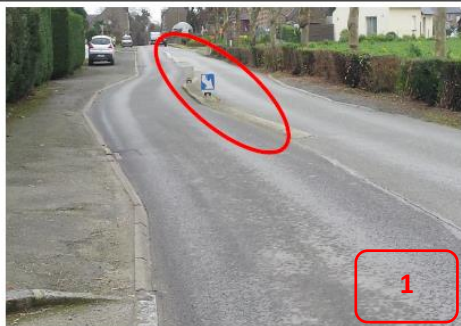
Bourg de Saint Lormel béton sur 400 Mtrs KM 03
