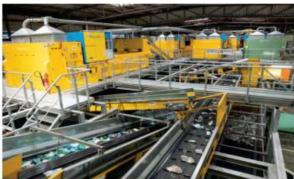
Un centre de tri de grande capacité pour séparer les emballages et les papiers.
