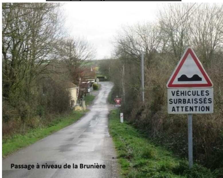
KM 38,7 passage à niveau surbaissé
