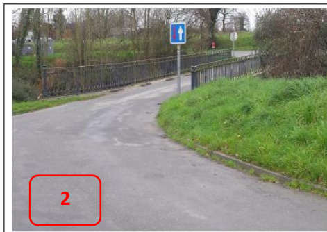
Pont de chemin fer Plancoët KM 26
