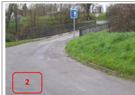
Pont de chemin fer Plancoët KM 26
