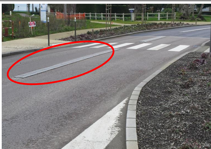
Sortie Corseul pavés centraux KM 39
