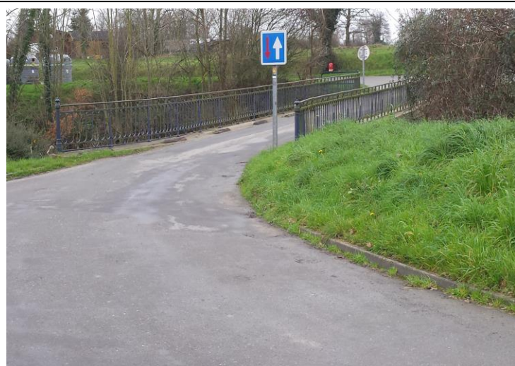
Pont de chemin fer Plancoët KM 26
