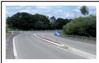
Sortie de Kergonan, virage à gauche, puis à droite : îlots centraux avec rétrécissement de chaussée ⇒ passage à droite.
