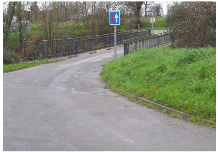
Pont de chemin fer Plancoët KM 26
